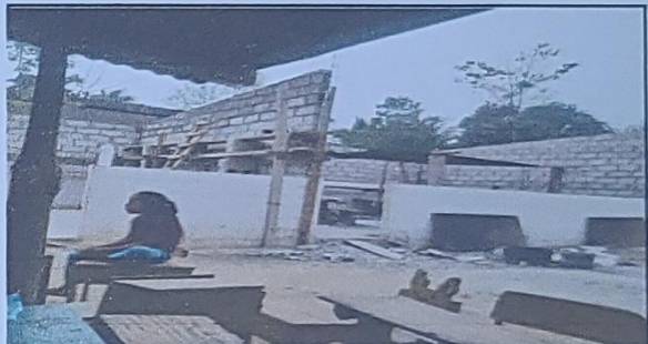
Foto 4: colocacion de piso
