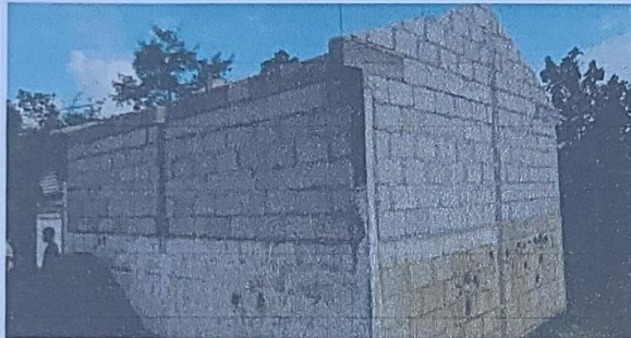
Foto 3: Reparacion de cocina
