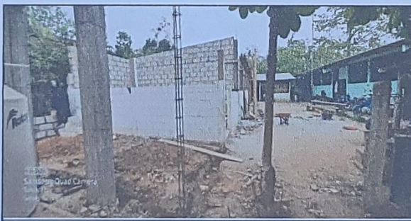
Foto 5: reparacion de aula
