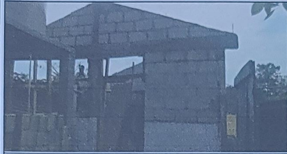
Foto 1: reparación de mojinete
